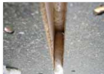
Pur in twee arbeidsgangen.
