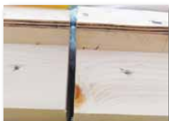
Open ruimte tussen de purlagen.
