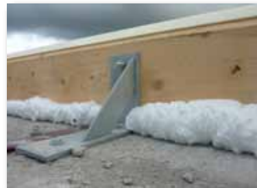
Goed aangebrachte luchtdichting.
