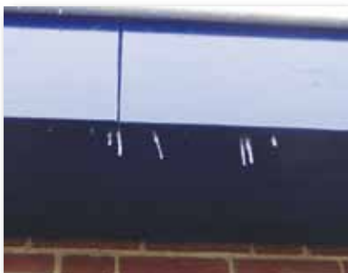
Luchtlekken in de dakvoet met ijspegels als gevolg.
