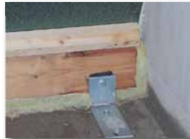
Goed aangebrachte luchtdichting.
