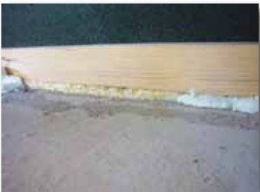
Fout: deels luchtopen minerale wol.
